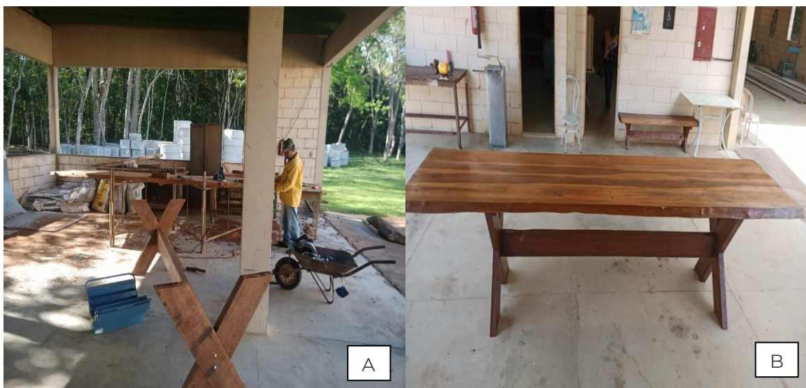
Figura 35. Refeitório do Centro de Manutenção A) B) Construção de mesa e bancos para bem-estar na hora do almoço dos funcionários.
