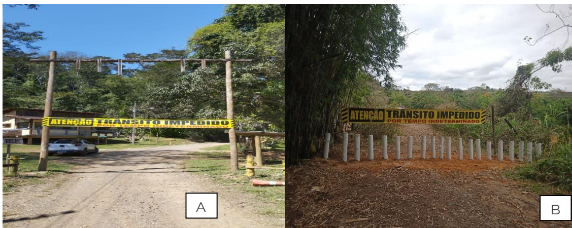
Figura 27. Ponte Queimada A) B) Aquisição e fixação de faixas indicativas de trânsito interrompido e construção de barricada, com a finalidade de evitar acidentes, considerando que a ponte se encontra inoperante, em decorrência de incêndio em parte de sua estrutura.
