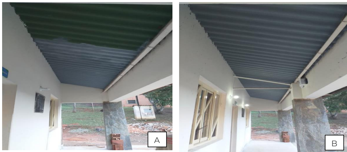
Figura 20. Centro de Pesquisa A) B) Início de acabamento com pinturas em toda área externa do Centro de Pesquisa próximo ao Herbário.
