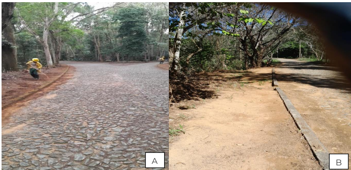
Figura 26. Estrada principal A) B) Limpeza em partes da estrada principal de acesso ao lago Dom Helvécio com capina manual das saídas de águas de chuva (enxurradas).
