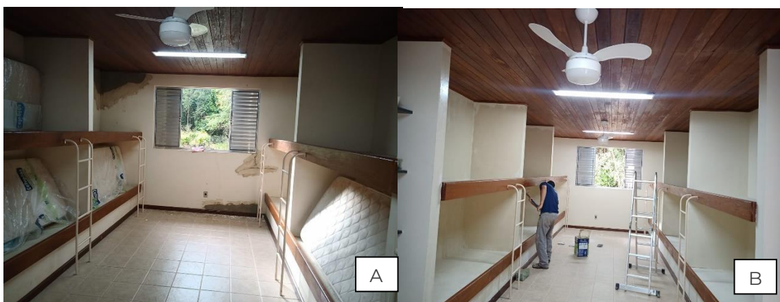
Figura 1. Alojamentos do Centro de Pesquisa A) B) Foram realizados reparos com areia, cimento e argamassa ACIII nas paredes. Toda pintura interna foi revitalizada com a aplicação de três demão de tinta palha no interior dos 6 alojamentos.
