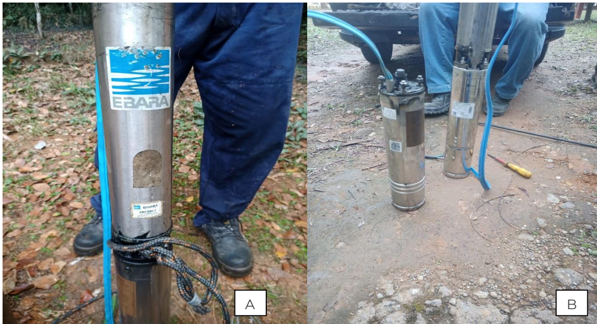
Figura 18. Poço artesiano A) B) Substituição e aquisição da bomba de abastecimento da caixa d'água para irrigação de mudas do viveiro (poço próximo à Casa das Flores).
