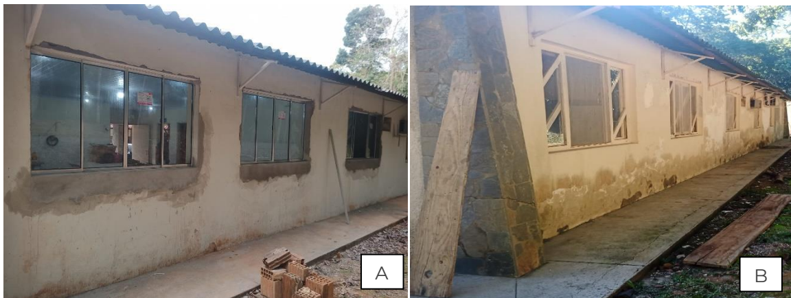
Figura 15. Centro de Pesquisa A) B) Substituição de janelas de metal enferrujadas por janelas de alumínio de correr 120x200cm, com 4 folhas de vidro liso.
