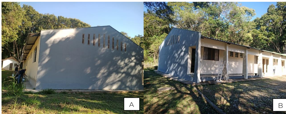
Figura 3. Alojamentos do Centro de Pesquisa. A) B) Finalizada a manutenção com aplicação de três demão de tinta na área externa nos 6 alojamentos do Centro de Pesquisa.
