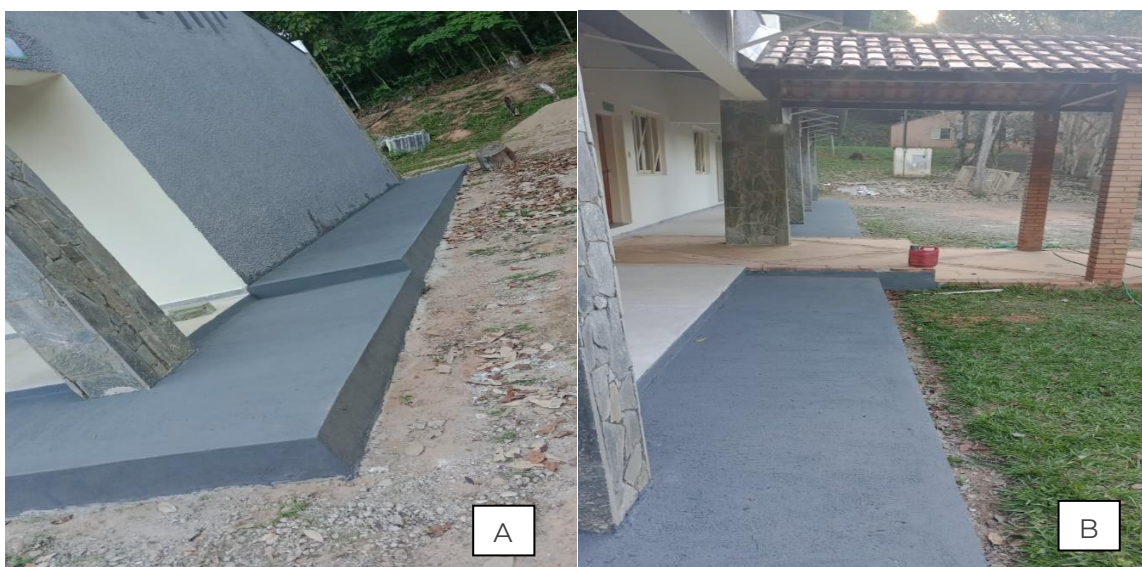
Figura 37. Herbário e Laboratório A) B) Pintura com três demão de tinta extra piso cinza escuro em toda calçada do entorno das estruturas.
