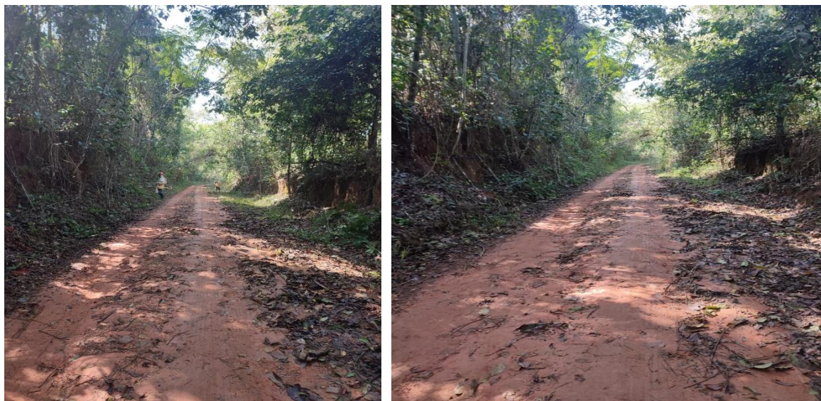
Figura 28. Estrada da Preguiça A) B) Limpeza com roçada mecanizada em 5km da estrada.
